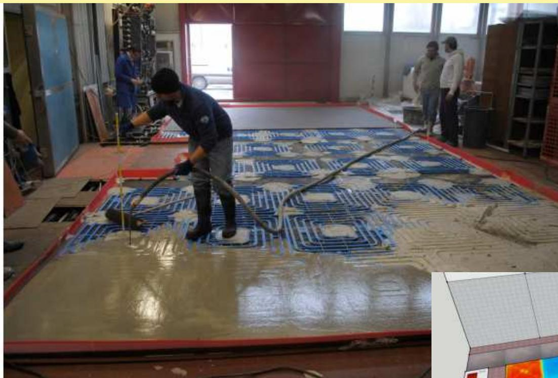
realizzazione di un sistema radiante a pavimento di 50 m<sup>2</sup> sul pavimento pregrado di sopportare carichi concentrati, con spessore totale di 30 mm
